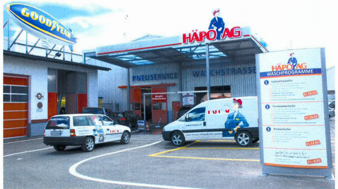
Nach kurzer Umbauzeit konnte die HÄPO AG ihre auf den neusten technischen Stand gebrachte Auto-Waschanlage wieder in Betrieb nehmen.
